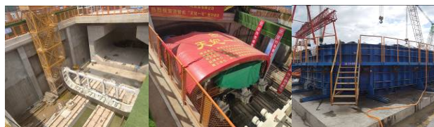
(a) 顶管盾构机拼装 (b) 装备调试 (c) 管节预制
