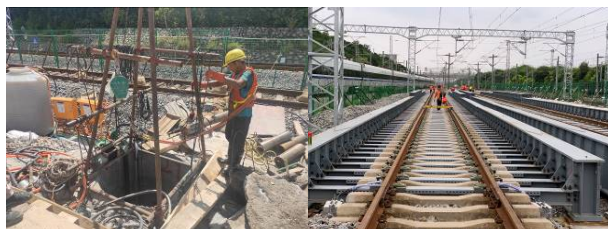
(a) 人工挖孔桩
