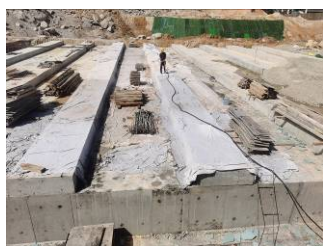
(c) 模板拆除
