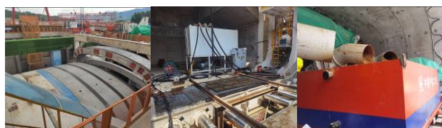
(g) 管节下井 (h) 管节顶进 (i) 渣土运输
